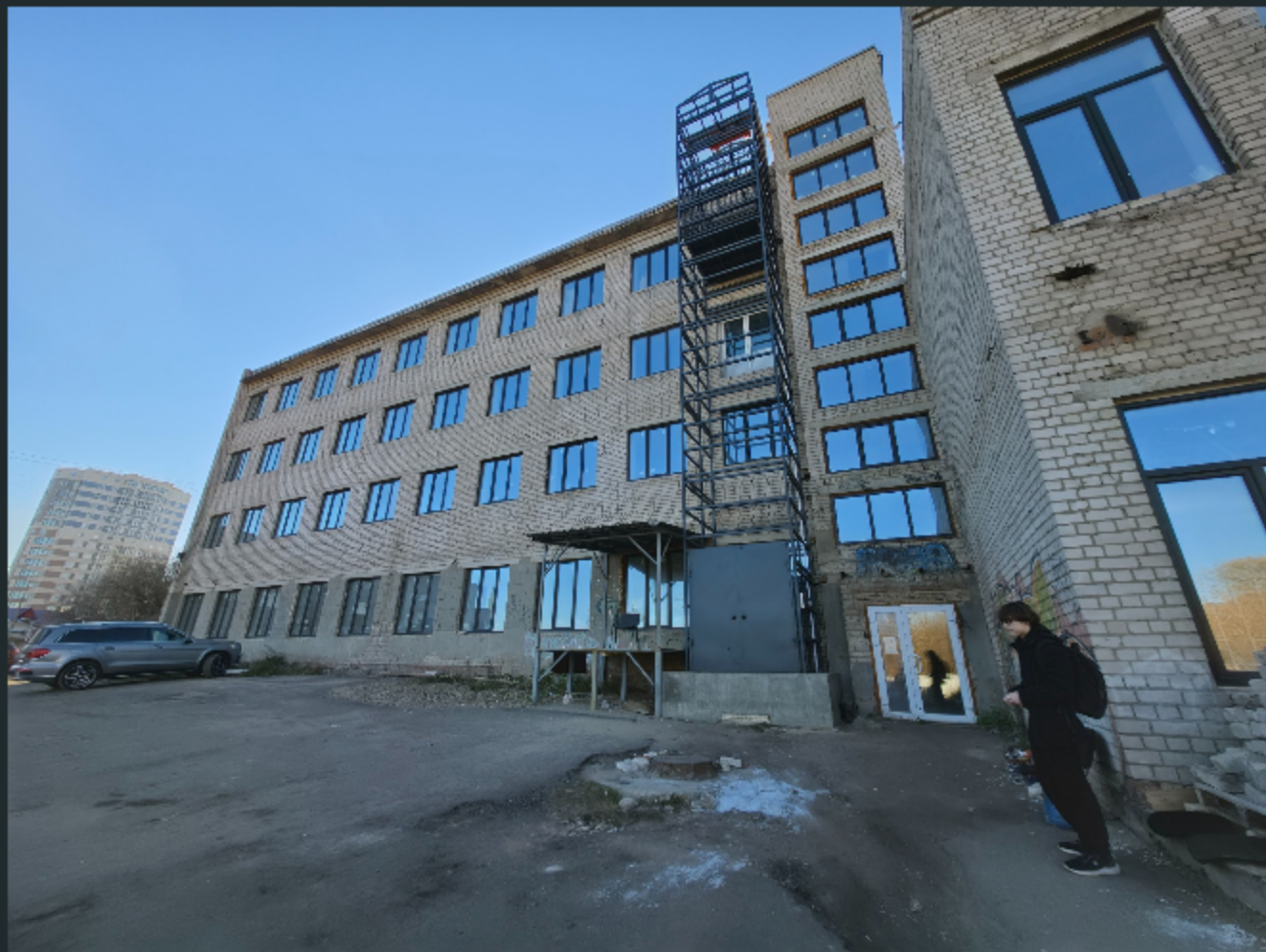
Фактический вид здания
